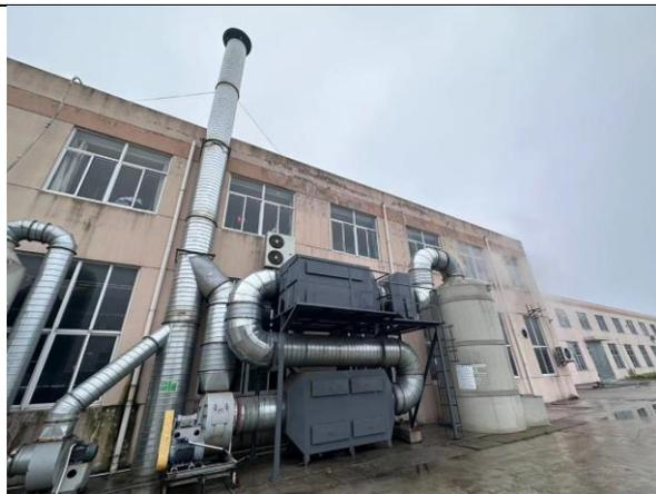
塑炼废气、密炼废气、开炼废气、压底废气、压延废气、干燥废气、搅浆废气、成型废气、上光废气、硫化废气、冷却废气处理装置（水喷淋+干燥装置+两级活性炭吸附）及排气筒
