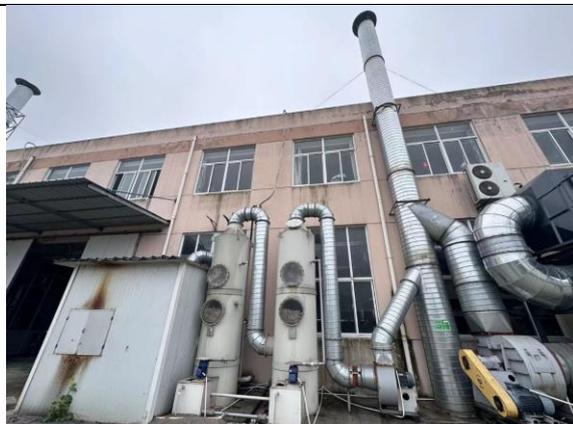
喷胶废气（两级水喷淋）及排气筒
